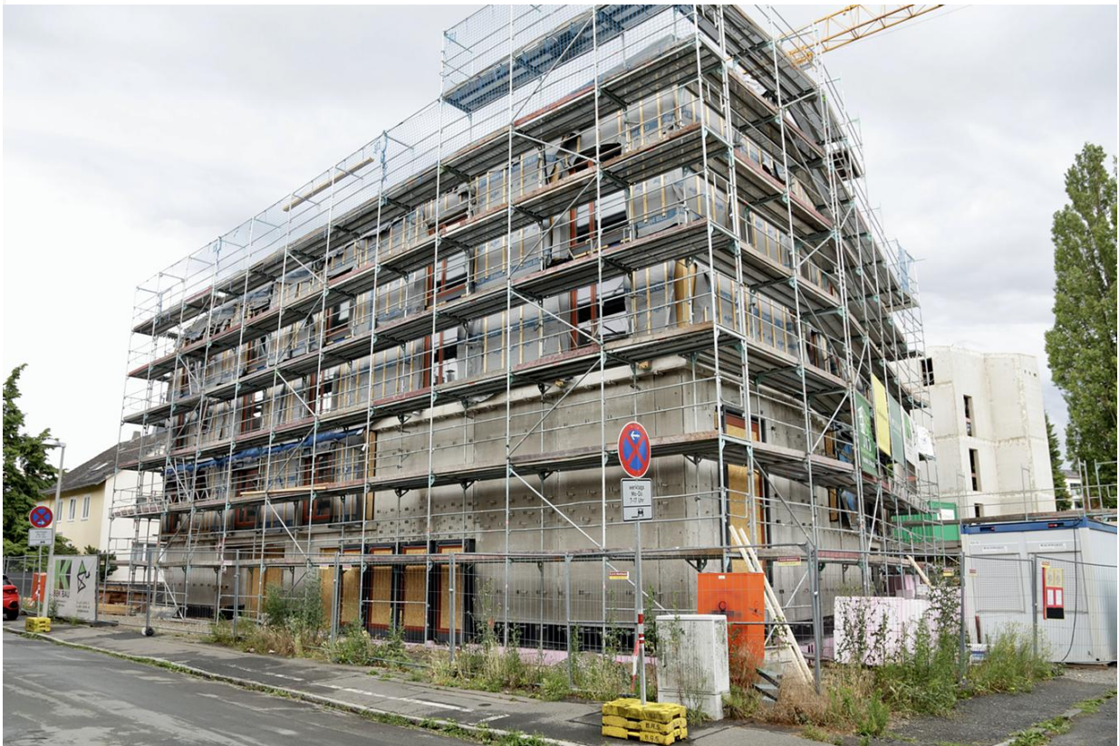
Der Rohbau am Alveser Weg. Die Kirchenräume befinden sich in den unteren Etagen.
